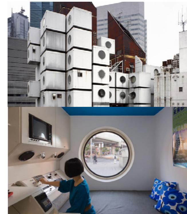
La Nakagin Capsule Tower est un immeuble construit en 1972, dessiné par Kisho Kurokawa et situé dans le quartier de Shimbashi, Tokyo, Japon. Sur deux tours en béton sont greffées des « capsules » de 2,3 m x 3,8 m x 2,1 m qui sont autant de petits espaces de vie ou de travail et qui peuvent être combinés pour créer des espaces plus grands. Elles sont entièrement aménagées et équipées.
